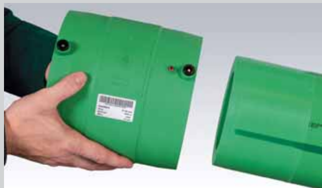
Nataknuti E-spojnicu na kraj cijevi
