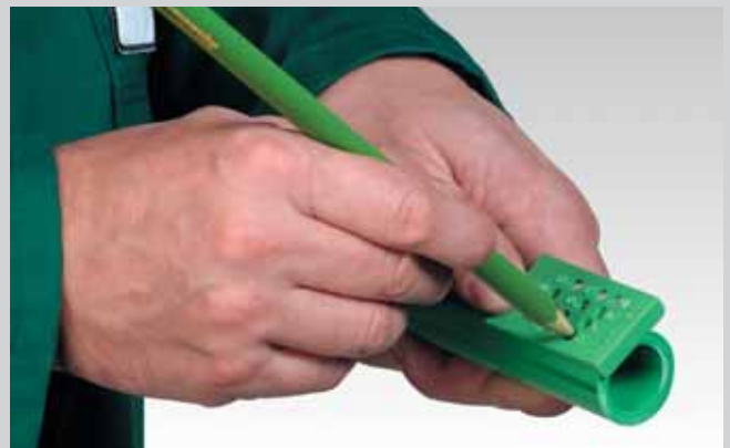
Označavanje dubine zavarivanja
