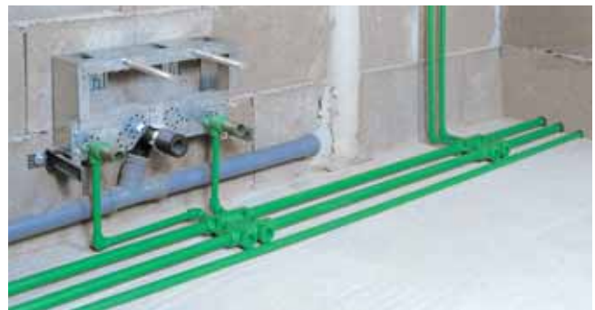
Razdioba po katovima s razdjelnim blokovima
