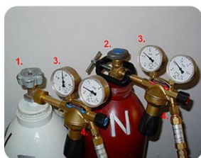
(1 i 2) – ventil boce za priključak redukcijskog ventila, (3) – manometar koji mjeri tlak u boci
