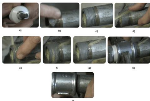
Brtvljenje cijevnih navoja pomoću Loctite 577
